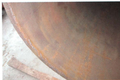
Рис. 1. Фотография контрафактной трубы диаметром 1420 мм, которая выдавалась за новую продукцию. На торце отчетливо видны следы вырезки из трубопровода
