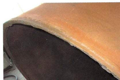
Рис. 2. Фотография еще одной контрафактной трубы диаметром 1420 мм из той же партии. Также отчетливо видны следы вырезки из трубопровода: помимо неровных кромок присутствует кольцевой сварной шов (бывший стык труб в трубопроводе)
